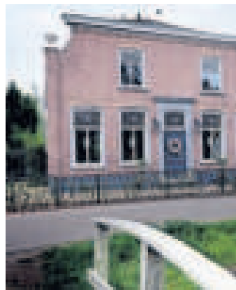
▲ Bij de zeer intensieve verbouwing hebben Sheila en Jan van den Berg de authentieke details in de burgemeesterswoning in Goudriaan zo veel mogelijk behouden.
